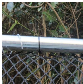
ネットをトップバーに結束バンドで仮止め
