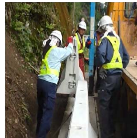
基礎擁壁の設置状況(2)
