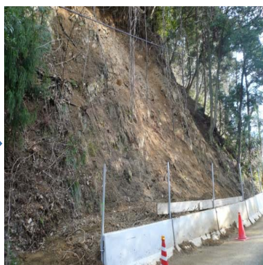
施工後：崩壊土砂を捕捉
