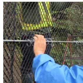
ネットジョイント設置
