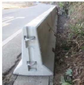
基礎擁壁の側面
