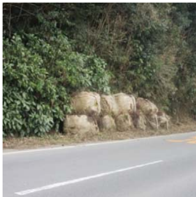
施工前：大型土のう
