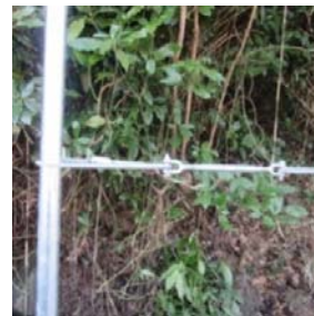
横ロープLとのPSターンバックルの接続
