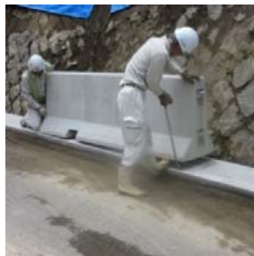
基礎擁壁の設置状況(1)
