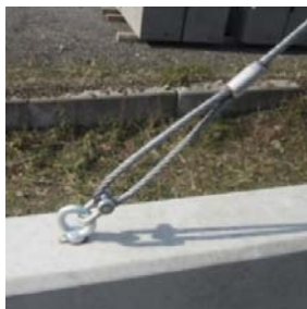
斜ロープと基礎擁壁を接続
