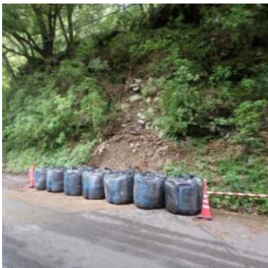
大型土のう対処事例
