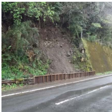
施工前：崩壊現場に仮設の木柵
