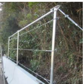
横ロープ設置完了
