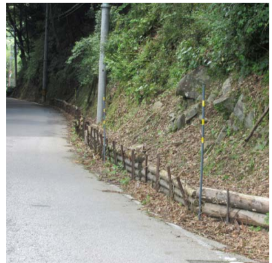
簡易木柵による対処事例
