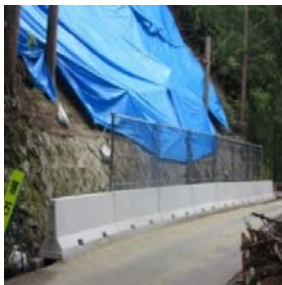
崩壊斜面下に仮設で設置
