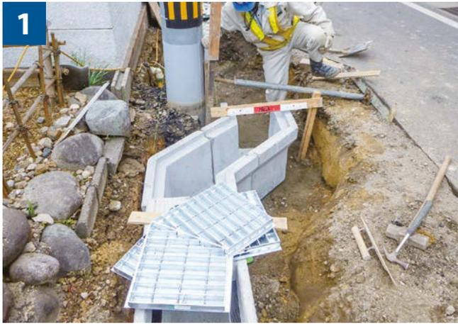
1 ペイパブル電柱よけ側溝本体の設置
